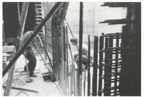
Fig. 10. - Boulonnage des tiges filetées.
