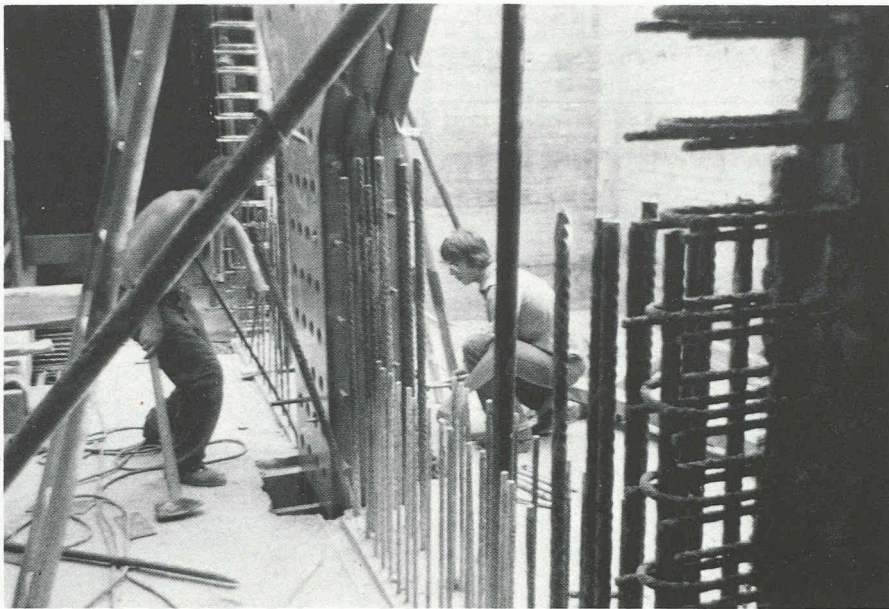
Fig. 10. — Boulonnage des tiges filetées.
