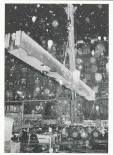
Fig. 5. — Montage de nuit d'un sommier caissonné.
