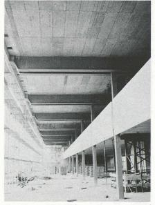
Fig. 15. — HEB 1000 jumelés sur colonnes forgées.
