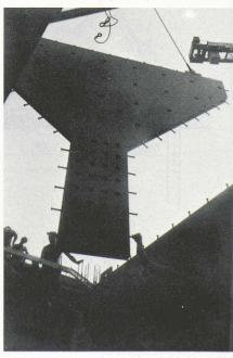
Fig. 9. - Mise en place d'une «tulipe».
