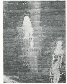
Fig. 4. – Efflorescence du béton.
