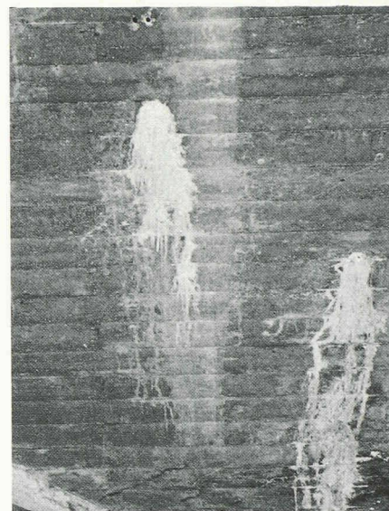
Fig. 4. — Efflorescence du béton.
