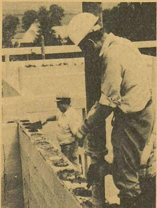
Le système garantit un travail rationnel lors du gros œuvre déjà; le montage en est encore facilité grâce au système d'assemblage de précision et sans joint.
