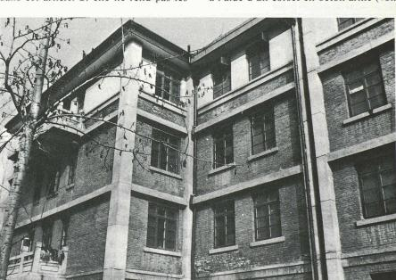
Fig. 1. - Vue générale d'un bâtiment avec son corset de nervures en béton armé.
