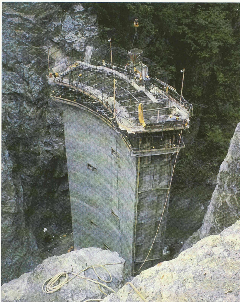
Fig. 24. — Plot central du barrage C monté par coffrage glissant.
