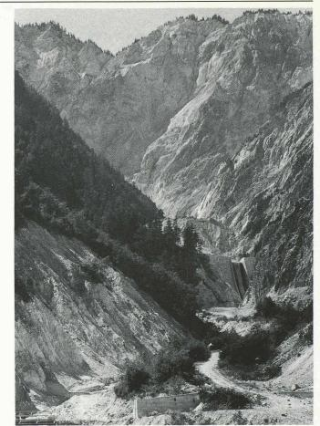
Fig. 13. — Vue du barrage de l'Illgraben. On distingue en amont la masse des éboulis retenus.
