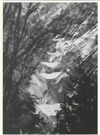
Fig. 12. — Vue de la correction du Grand-Torrent sur le Merdenson faite de seuils arqués en béton.
