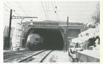
Deux ans et demi, avec deux hivers, séparent ces deux photographies. Les ponts métalliques ont disparu et le trafic s'écoule en toute sécurité sur le nouveau pont couvert, capable de résister aux avalanches. Sur la photographie de droite, on distingue les premiers travaux de la galerie qui prolongera le pont sur une longueur de 45 mètres.
