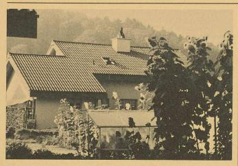
rement dans la zone de transition que l'utilisation de l'élément «Structa» s'est avérée un matériau intéressant et utile de transition. En effet, contrairement à la grande plaque ondulée «Eternit», l'aspect de «Structa» est plus vivant, moins monotone. Elle s'intègre mieux aux toitures de tuiles environnantes, car la différence n'est pas perceptible dans l'image globale. La couleur brune se combine avec les teintes subtiles de la terre cuite.»
