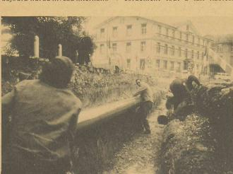
Les tuyaux en PVC sont mis en place sans engin de manutention, d'où diminution sensible des frais de pose.
