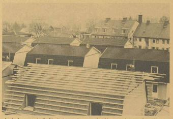
Après la pose de l'« Underlagstak », une feuille en polypropylène thermosoudé «Typar» bitumé, les tuiles noires Decra peuvent être montées rapidement et en sécurité sur la maison du type Thermohus visible au premier plan, afin de servir comme collecteurs de chaleur solaire pendant l'hiver. Cela fait partie d'un ensemble de 62 maisons à Sala, près de Stockholm.
