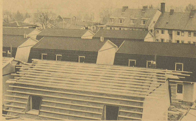
Après la pose de l'«Underlagstak», une feuille en polypropylène thermosoudé «Typar» bitumée, les tuiles noires Decra peuvent être montées rapidement et en sécurité sur la maison du type Thermohus visible au premier plan, afin de servir comme collecteurs de chaleur solaire pendant l'hiver. Cela fait partie d'un ensemble de 62 maisons à Sala, près de Stockholm.
