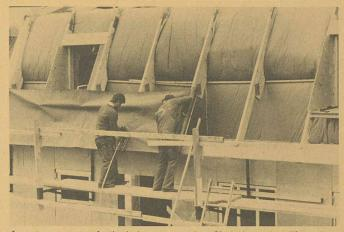
La mise en œuvre facile de la sous-couche « Underlagstak » d'Icopal est due au faible poids et aux bonnes propriétés mécaniques du matériau. La résistance élevée à la traction, aux déchirures et à la perforation du polypropylène thermosoudé «Typar» protège les ouvriers couvreurs contre les chutes accidentelles.
