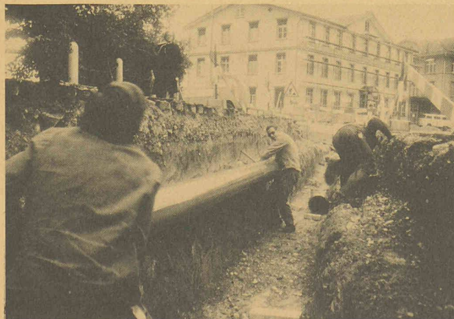
Les tuyaux en PVC sont mis en place sans engin de manutention, d'où diminution sensible des frais de pose.
