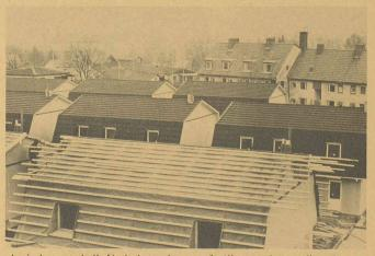
Après la pose de l'« Underlagstak », une feuille en polypropylène thermosoudé «Typar» bitumé, les tuiles noires Decra peuvent être montées rapidement et en sécurité sur la maison du type Thermohus visible au premier plan, afin de servir comme collecteurs de chaleur solaire pendant l'hiver. Cela fait partie d'un ensemble de 62 maisons à Sala, près de Stockholm.
