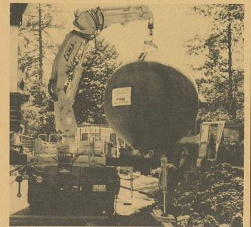
Fig. 1. — L'équipe RAG met en terre la citerne cuirassée : un système simple, propre, rapide.
