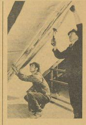
fixation est faite le long des chevrons au moyen de lattes clouées. Le montage de la sous-toiture se fait depuis la gouttière jusqu'à 5 cm en dessous du faîte (pas pardessus le faîte) de manière à disposer d'un espace libre également aussi de 5 cm pour assurer une bonne ventilation au-dessous de la sous-toiture. L'isolation est ainsi protégée de façon optimale de tous les agents atmosphériques.
