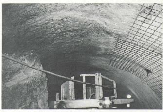
Fig. 3. — Détail de la partie horizontale de la galerie Felskinn. Pour la consolidation, on a posé des treillis en acier en partie ancrés, recouverts de mortier projeté pour lequel on a souvent utilisé du Sika Shot 3, mélange sec prêt à l'emploi pour mortier de gunite. (Photo: Daniel Quinche, 1026 Echandens.)
