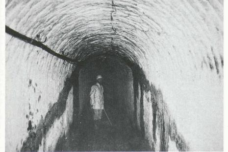
Fig. 4. — Suintements au niveau d'un interlit marneux dans le séquanien moyen à 435 m du portail nord.
