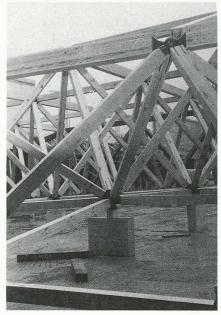
Fig. 8. — Halle polyvalente d'Arbon en cours de montage.
