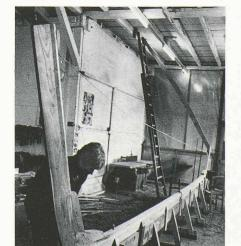
Fig. 8. - Mise en chantier d'un canot chez Sartorio à Mies. L'étrave, la quille et le marsouin (pièce de bois fixant le tableau sur la quille) sont assemblés et alignés.
