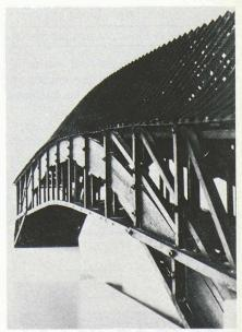
Maquette originale du pont sur la Limmat à Wettingen par Hans Ulrich Grubenmann (1777/78). Le cintre en poutres superposées et chevillées précède de près de 200 ans les formes modernes réalisées en bois lamellé-collé.
