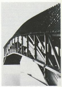
Maquette originale du pont sur la Limmat à Wettingen par Hans Ulrich Grubenmann (1777/78). Le cintre en poutres superposées et chevillées précède de près de 200 ans les formes modernes réalisées en bois lamellé-collé.
