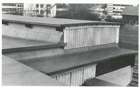
Fig. 3. — Toiture plate résistante aux intempéries sans couverture de sable et de gravier.
