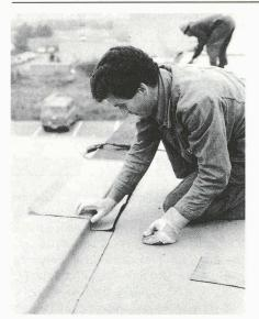
Fig. 4. — Exécution d'une étanchéité de toit plat résistante aux intempéries.
