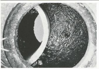
Fig. 4. — Vue du premier compartiment d'une fosse septique. La boue flottante est absente de la partie située avant la paroi plongeante.
