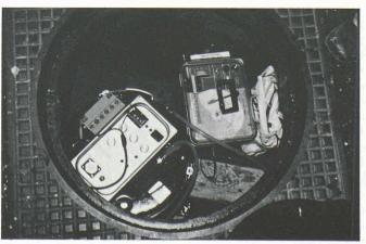
Fig. 2. — Débimètre et préleveur automatique installés.
