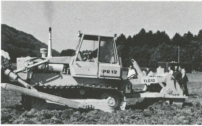
Fig. 2. — La pression démographique suscite la mise en valeur pour l'agriculture de terrains peu favorables, au prix souvent d'une véritable débauche énergétique : essais de défoncement d'un sol hydromorphe pour accroître sa perméabilité. (Photo M. Pochon.)
