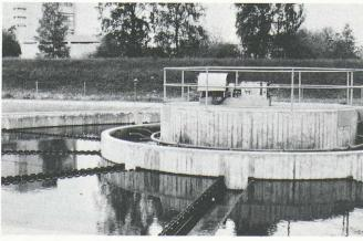
Fig. 5. — Station d'épuration — Bassin de décantation.
