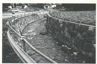
Fig. 6. - Correction de torrent.
