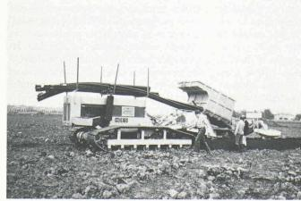
Fig. 3. — Machine à poser les drains en action.
