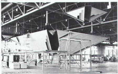
Vue d'ensemble du STAND D'EXPOSITION DE LA REPUBLIQUE FEDERALE D'ALLEMAGNE A TELECOM'83. Genève qui aura nécessité une ossature métallique de 30 tonnes et près de 1500 m² de tôles de façades — Montage en 9 jours
