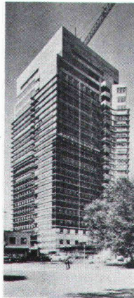
Revêtement de façade
