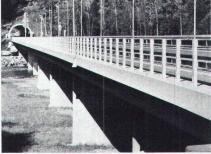
Pont sur autoroute Revêtement résistant au gel/dégel et aux sels à dégeler
