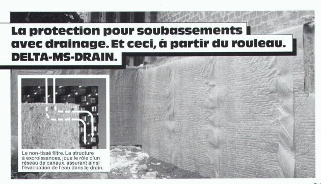
DELTA-MS-DRAIN: la protection pour soubassements, à deux couches.
