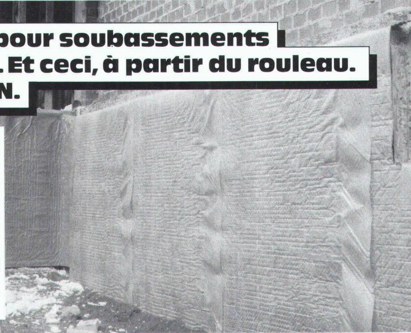
DELTA-MS-DRAIN: la protection pour soubassements, à deux couches.
