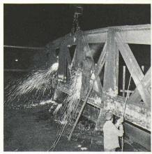
Fig. 2. — Démolition de l'ancienne structure àl'aide de grue-rails 25 t du type «Vevey», par l'équipe des ponts du 2<sup>e</sup> arrondissement CFF.
