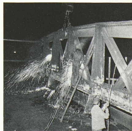
Fig. 2. — Démolition de l'ancienne structure à l'aide de grue-rails 25 t du type «Vevey», par l'équipe des ponts du 2 e arrondissement CFF.
