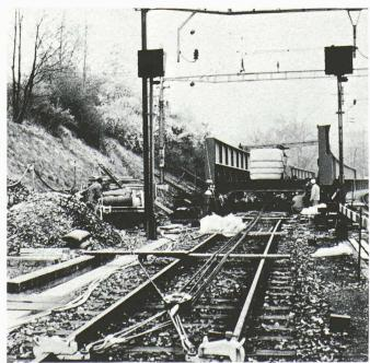
Fig. 10. — Dernier lancement du pont amont, avec treuil et mouflage de retenue, citernes faisant contre-pieds, pont roulant de chantier, jougs et mâts de signalisation restés en place.
