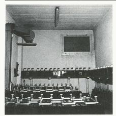
Fig. 4. — Pièce réservée aux accumulateurs pour l'alimentation de secours d'un chemin de fer. Le détecteur de gaz monté au plafond surveille la concentration en H<sub>2</sub> et met automatiquement en marche le ventilateur en cas de nécessité. (Photo Cerberus)
