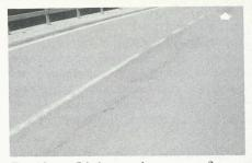
Fig. A2. — Dégât au revêtement avec fissures du tapis hydrocarboné dues à la poussée. Les teneurs en vides de la partie du revêtement endommagé s'élevaient à: 5,1-7,5% (volume) dans la couche d'égalisation; 4,0-7,4% (volume) dans la couche d'usure. (La flèche indique l'endroit où l'on a prélevé un échantillon; cf. fig. A3.)
