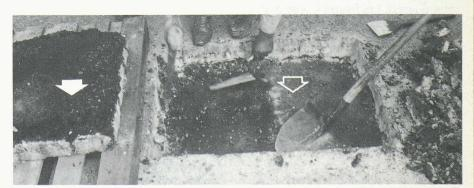
Fig. B6. — Echantillon 3: le revêtement peut pratiquement être enlevé en bloc et sans être endommagé (épaisseur 13 cm). Au-dessous, l'étanchéité est intacte. De plus, elle adhère encore fermement au béton. On ne constate aucun enduit d'accrochage entre l'étanchéité et le revêtement.
