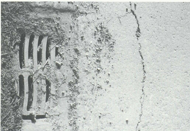
Fig. E1. — Fissuration visible de l'enrobé.
