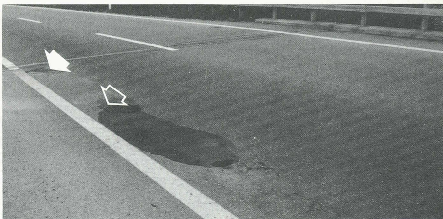
Fig. B2. — Vue en direction du joint de dilatation inférieur où un trou provoqué par des chocs a été réparé; l'échantillon 1 a été prélevé dans cette zone à l'avant de la réparation longitudinale du revêtement.
