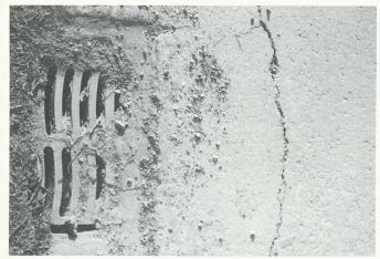
Fig. E1. — Fissuration visible de l'enrobé.
