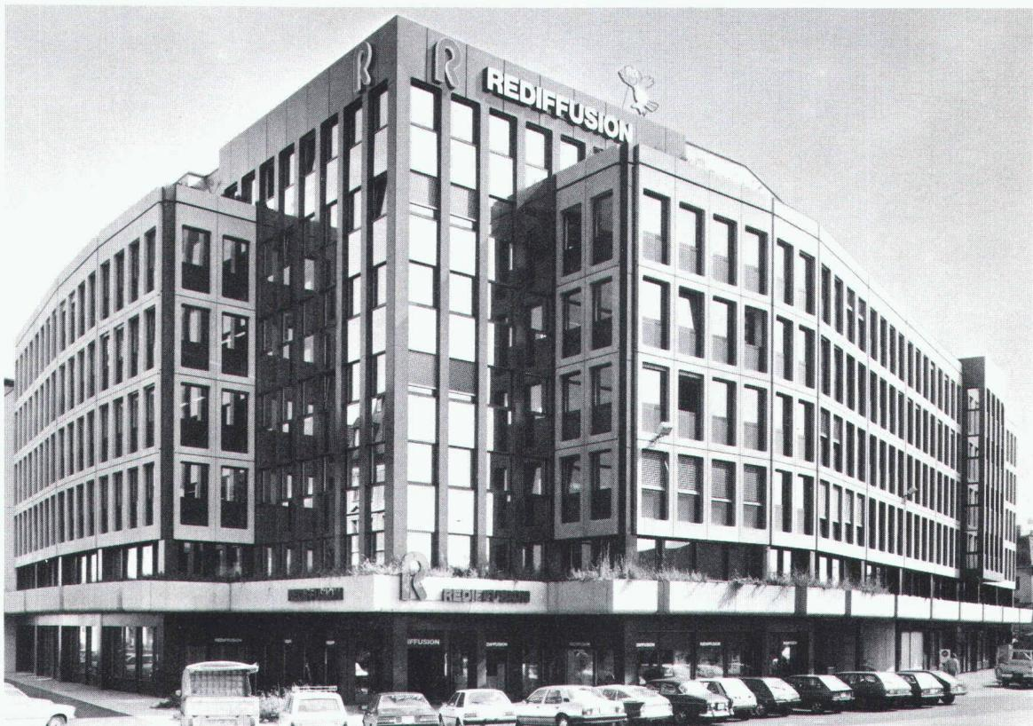
Cette façade, répondant parfaitement aux impératifs de la physique du bâtiment, est conçue avec des encadrements suspendus en béton. Ceux-ci sont teintés et leurs faces visibles sont sablées.
