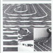
«Gabotherm» — Le nouveau système de chauffage par le sol avec une technique rationnelle de pose. Seulement 2 phases de travail!
