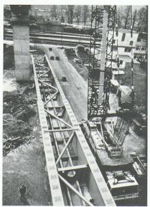
Fig. 8. — Viaduc de Goldswil en cours de montage (1982); hauteur des poutres 2300 mm, épaisseur en travée 13-14 mm; portées  $30.7 + 45 + 50 + 71.1 + 2 \times 45 + 81 + 65 + 55 + 42 m$ .
