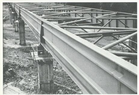
Fig. 2. — Viaduc sur la Sorge en cours de montage (1973); hauteur des poutres 2100 mm, épaisseur en travée 10 mm; portées  $23+3\times30+43.5+4\times36.5+37.5$  m.
