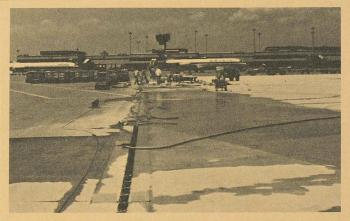
Fig. 5. — Polydrains posés dans du béton armé.
