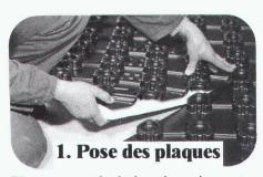
Plaques avec isolation thermique et phonique, barre vapeur et supports de tubes intégrés
