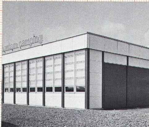
Ce bâtiment industriel a été construit par Frutiger en 6 semaines. L'édifice, de type non-conventionnel, dispose d'une hauteur d'étage utile de 5,2 m – l'hauteur double des unités de montage. Les dimensions intérieures correspondent aux exigences de l'entreprise.
