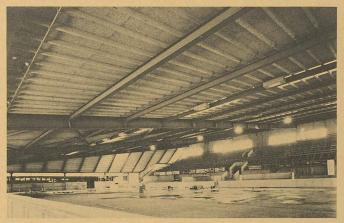
Patinoire artificielle de Dübendorf: 3900 m², Schichtex-Spécial 125/III, format 200 × 64 cm, avec battues des 4 côtés, côté visible avec peinture jaune au pistolet.
