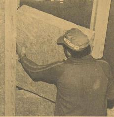
C'est ainsi que le nouveau panneau isolant Flumroc Tria doit être coupé: la largeur exacte est obtenue en déplaçant un triangle par rapport à l'autre; ensuite, il suffit de couper les deux coins.
