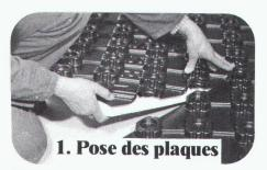
Plaques avec isolation thermique et phonique, barre vapeur et supports de tubes intégrés
