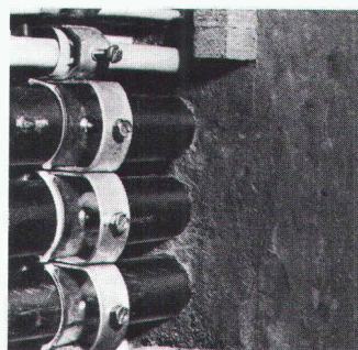
Séparation type VAM-W pour traversées de parois
