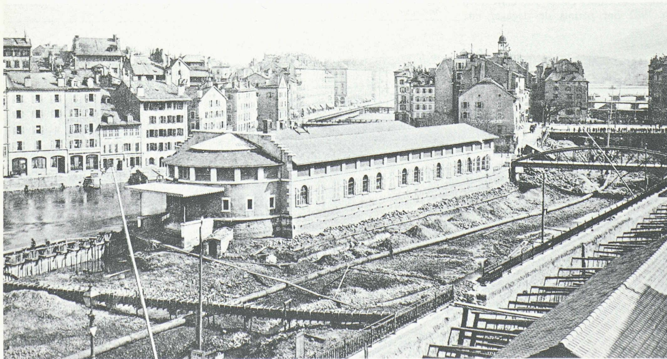
Fig. 9. — Approfondissement du bras gauche du Rhône. Mars 1884.
