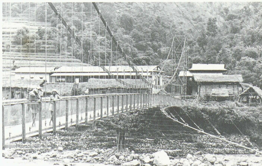
Pont suspendu à Badighat (Inde). Portée: 79 m. Conception: Martin Burn, Calcutta; 1975.
