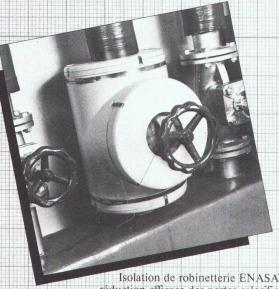
Isolation de robinetterie ENASAVE, réduction efficace des pertes calorifiques des vannes ou robinets.
