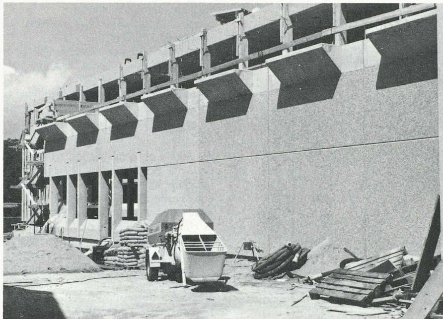
Façade sud: les consoles qui supporteront les bacs à fleurs.
