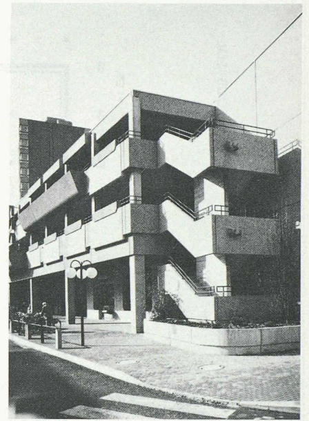
Fig. 2. — Détail de la façade sur la rue de Neuchâtel.
