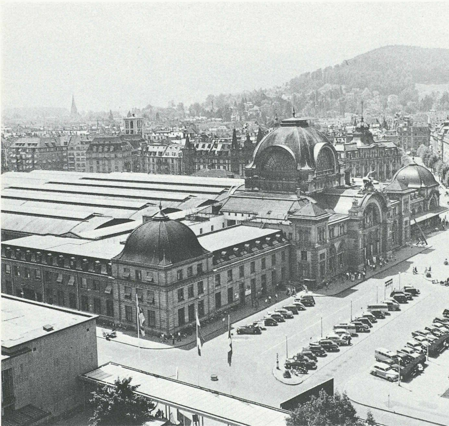
Il y a déjà plus d'un siècle que le chemin de fer participe également à l'urbanisme: la gare de Lucerne, partiellement détruite par un incendie et qui va faire l'objet d'une reconstruction adaptée aux exigences d'aujourd'hui (page ci-contre).
