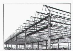
Structure métallique d'une usine - toiture mini-shed
