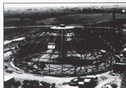
Coupoles destinées à l'entreposage du Clinker au Nigéria
