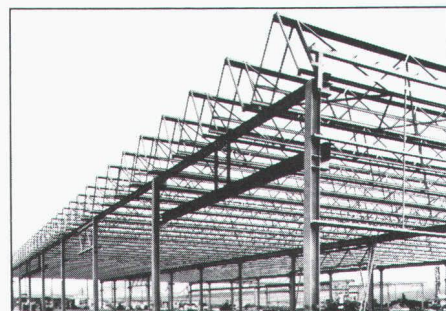
Structure métallique d'une usine – toiture mini-shed –
