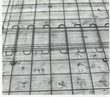
Fig. 10. — Joint de recouvrement des treillis «Static» (à gauche). Joints de recouvrement facilement contrôlables à boucles «Artec 20» (milieu) et «Artec 45» (à droite).
