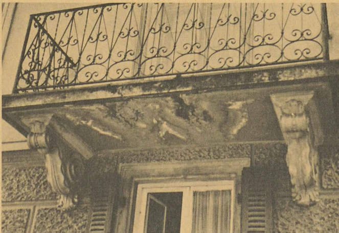
Miracote: assainissement d'un balcon
