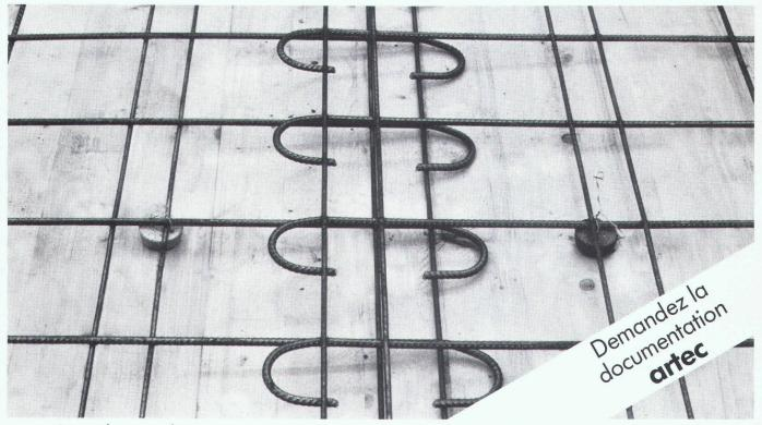
Avec la combinaison des boucles et des doubles barres (brevet dép.)
