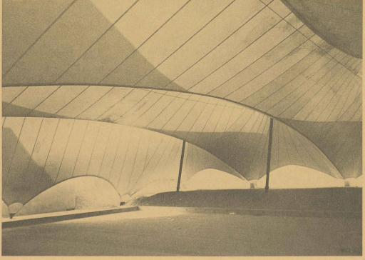
Les mâts de la construction SarnaTent ont 15 m de hauteur. Sous le toit, il règne une lumière du jour diffuse et (Photos: Sarna Plastiques SA, Sarnen) les utilisateurs sont protégés des rayons directs du soleil.
